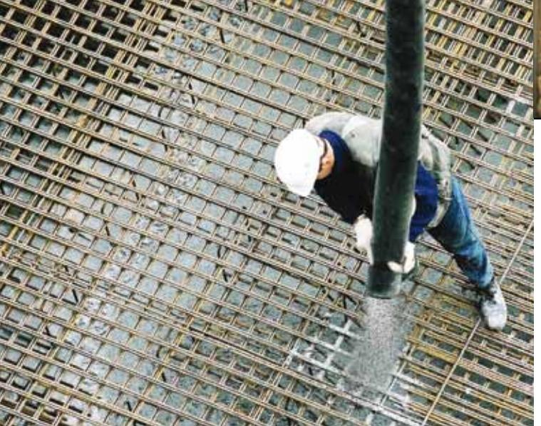
**Eksperimentalna istraživanja i praksa su pokazali da je optimalna temperatura za hidrataciju cementa u betonu između 5°C i 30°C, te je betoniranje u ovakvim uslovima okoline preporučljivo.**
