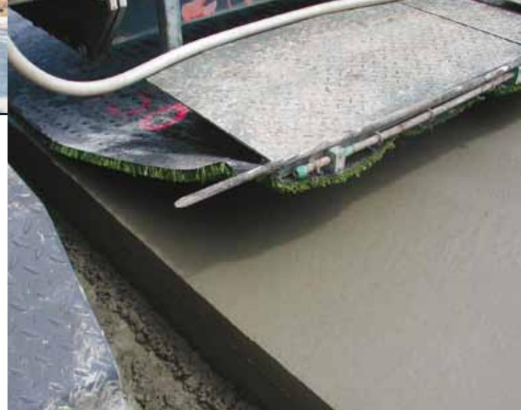
nisu dale traženi rezultat moguće je uraditi učinkovit način hlađenja gotovog betona primjenom tečnog dušika.
