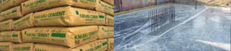
Smanjenje rizika od pojave termičkih pukotina može se postići određenim tehnološkim mjerama prilikom **proizvodnje, ugradnje i njegovanja betona**. Najjednostavniji način jeste **upotreba cemenata niske toplote hidratacije**.
